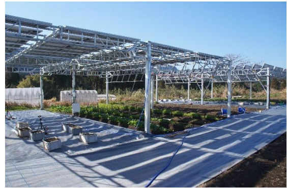
写真 1 営農型太陽光発電設備
