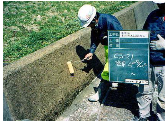
写真1. けい酸塩系表面含浸材 躯体面塗布
