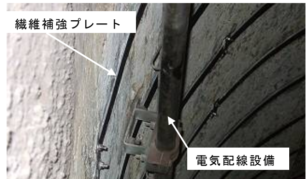
図-3 電気配線設備部詳細
