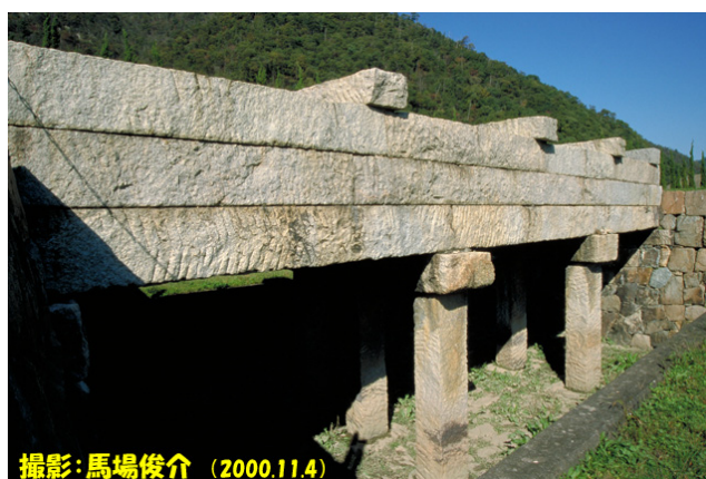
田原用水の旧懸樋 (Tahara-yosui aqueduct)
