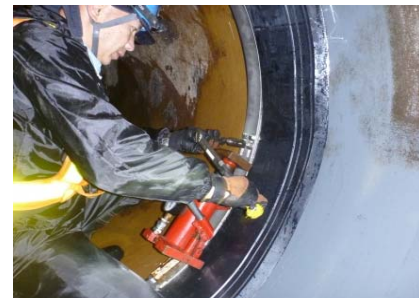
図 1 止水バンド設置模式図と設置状況
