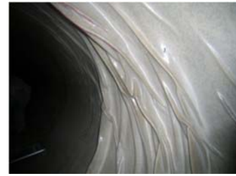
図2 反転工法の施工模式図と曲線部の発生シワ
