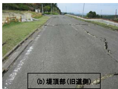
写真 1 上流面および堤頂部の被害状況
