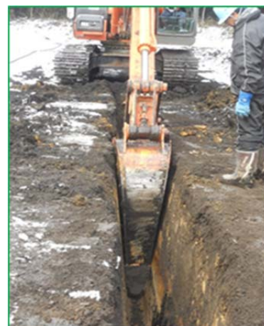
写真1 細型特殊バケット掘削状況
