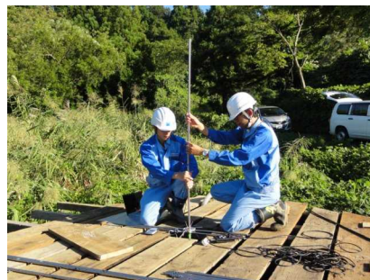
図-2 画像計測用カメラの挿入状況
