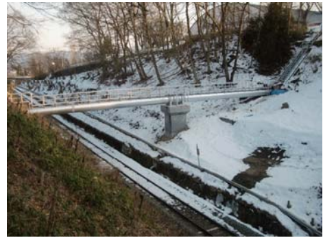
図-1 水管橋 全景（完成）
