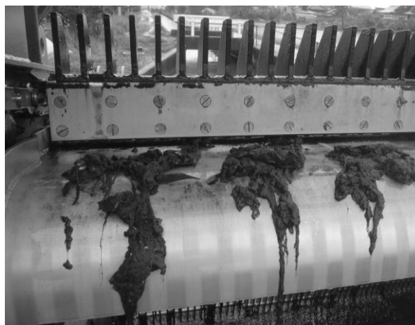
写真1 除塵機で除去された糸状性藻類 Filamentous algae on the dust remover
