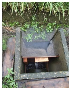
写真 1 調整板を設置した落水口
