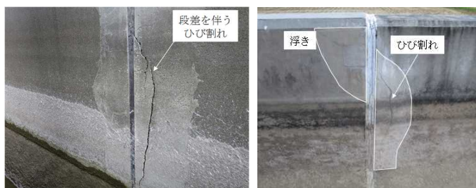
Fig. 1 目地近傍の変状例
