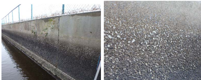
写真 1 水路全景と詳細状況
