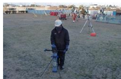
写真-3 磁気ロケータによる計測 Monitoring by the Locator
