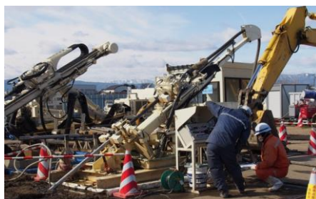
写真-2 注入専用機 Grouting equipment
