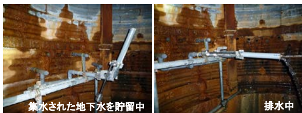
写真-5 集水管閉塞防止器
