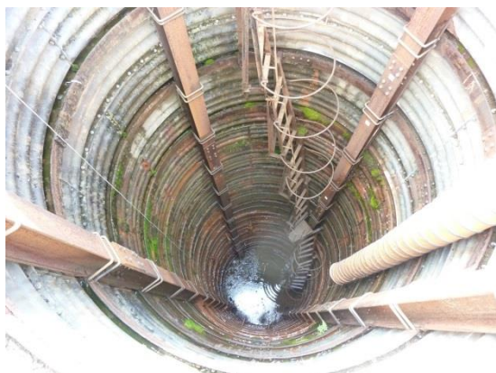
写真-1. 施工前の状況
