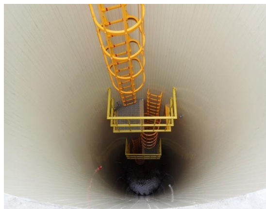
写真-2. 施工後の状況
