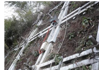
写真2 荷重計設置状況
