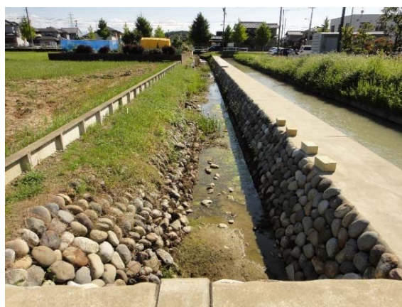
図1 石川県能美市の竹藪用水の水涸れ （最上流部より下流方向，2015年9月30日）
