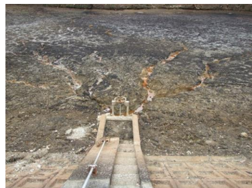
写真3 柳谷池（2017年12月8日撮影） （カイボリで排泥され、池底にミオ）
