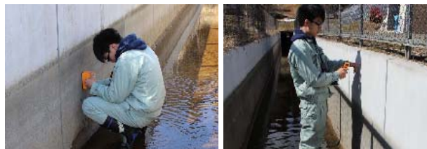
写真-1 表面水分量と温度測定状況
