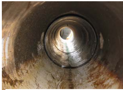
Pic.2 FRPM 管内 (最大たわみ率 3%以下)
