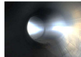
図 5 曲線部の管内面状況
