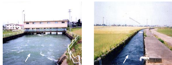
Fig.2 従前の開水路形式の幹・支線水路の状況
