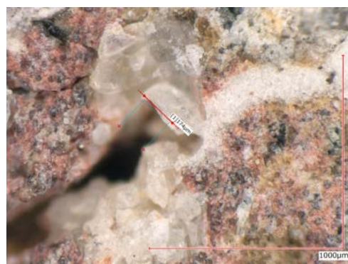
図-2 開発樹脂のひび割れ注入状況
