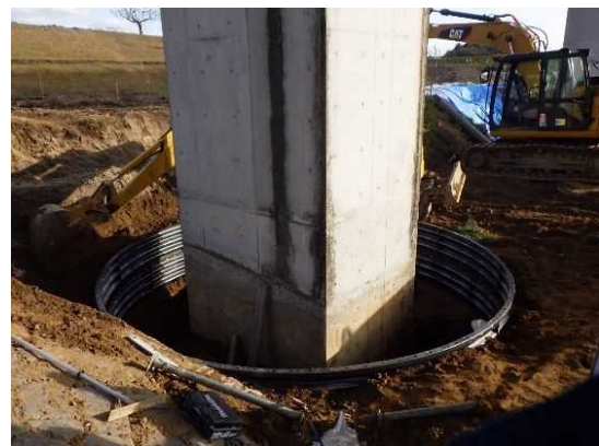
図-6 ライナーPLによる土留め工(P11) Fig.-5 Earth retaining with liner plate(P11)
