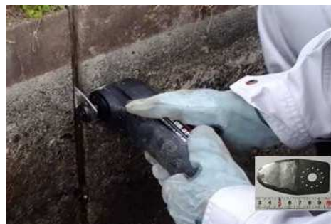
Fig. 3 マルチツール施工状況
