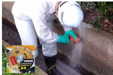
Fig.2 ディスクグラインダー施工状況
