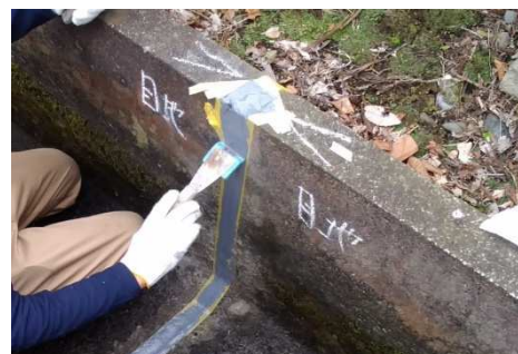
Fig. 4 シリコン製ヘラ施工状況
