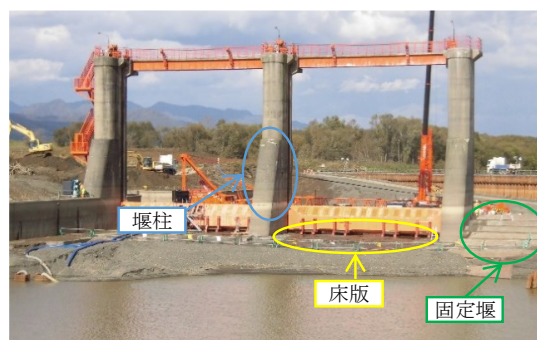
図-1 旧石狩川頭首工の外観
