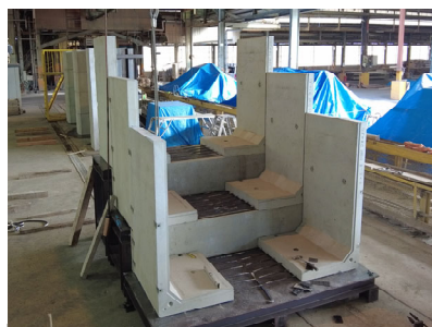
Fig. 3 L型ブロック階段施工
