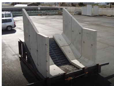
Fig. 4 L型ブロック斜路施工
