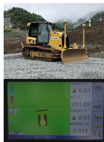
図-2 MC/MG 施工状況
