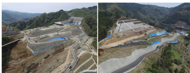
図-1 新東名高速道路川西工事の概要と施工状況
