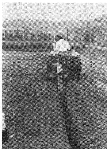
図-15 トレンチャーによる暗きょ掘削作業
