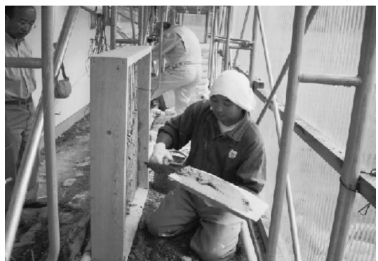
図-4 試験土壁作成の様子
