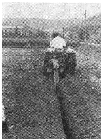
図-15 トレンチャーによる暗きょ掘削作業
