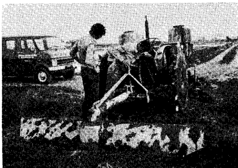
写真6 均平板の取付けと鉄車輪
