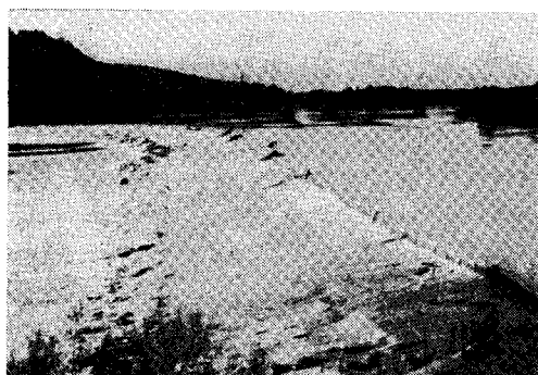
写真1 ポー河の取水堰
