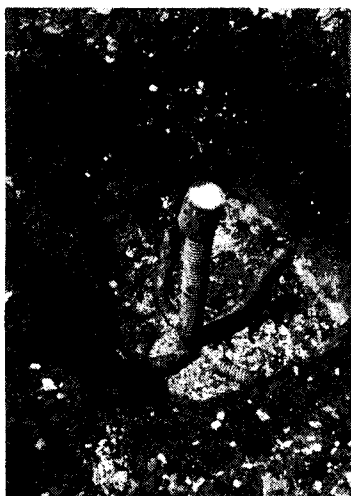
写真3 縦暗渠と普通暗渠の接合 —縦暗渠周辺には木材チップスを充填した—
