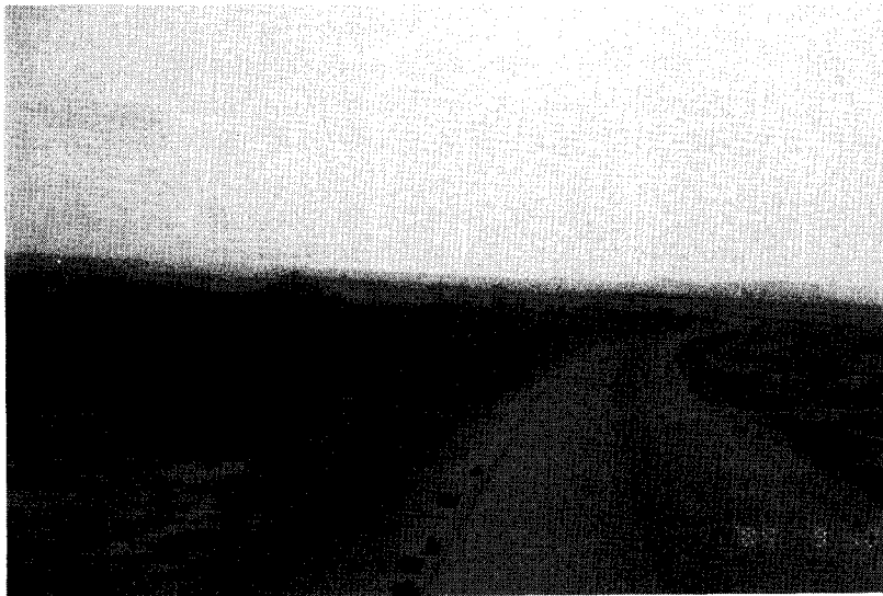
写真-3 道路盛土によって上流側に土壤水分がかん養されて植生が定着（ガオ）
