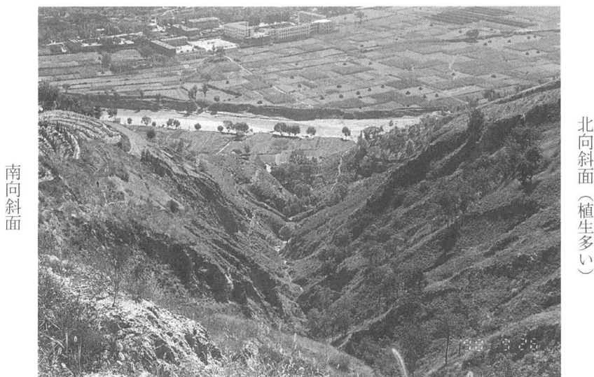
写真-1 南北斜面の状況
