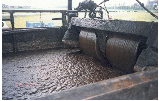
写真-4 浮上した油の回収状況
