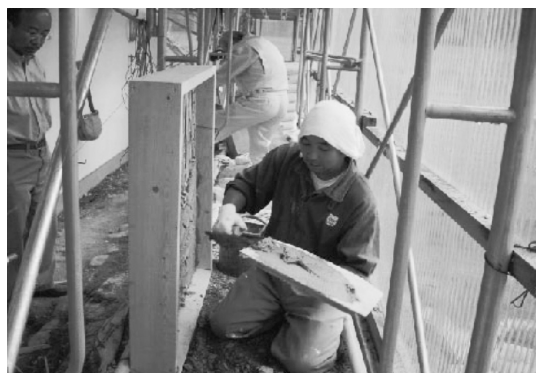
図-4 試験土壁作成の様子
