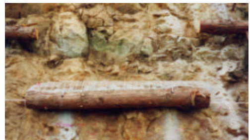
写真-3 間伐材にミラクルソールを 布設し、金網を設置した状況
