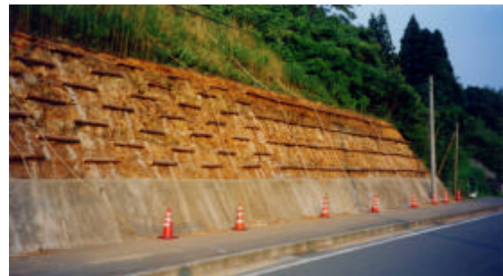
写真-4 間伐材の設置状況
