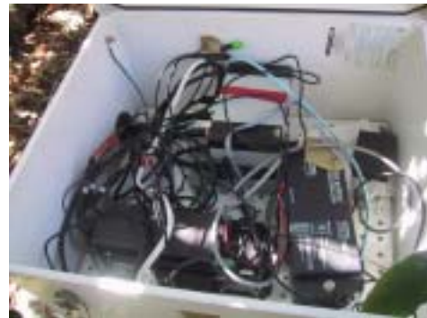
図 1 システムの設置状況
