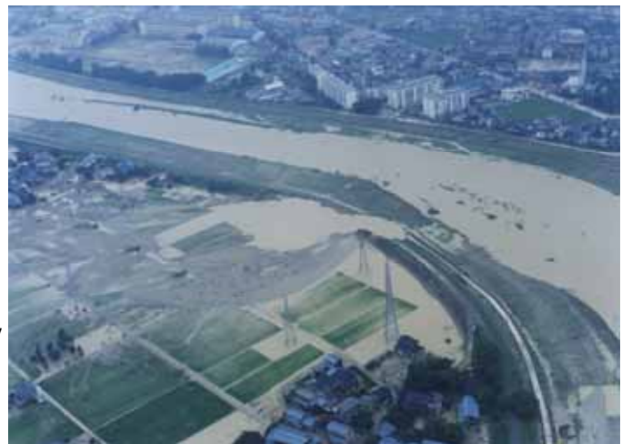
図1 五十嵐川破堤箇所(国際航業撮影) Embankment collapse of the Igarashi River
