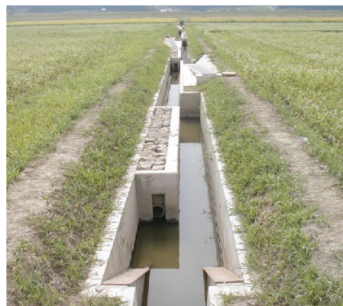
写真-1 生態系保全型水路
