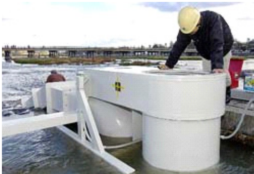
京都嵐山小水力発電所
