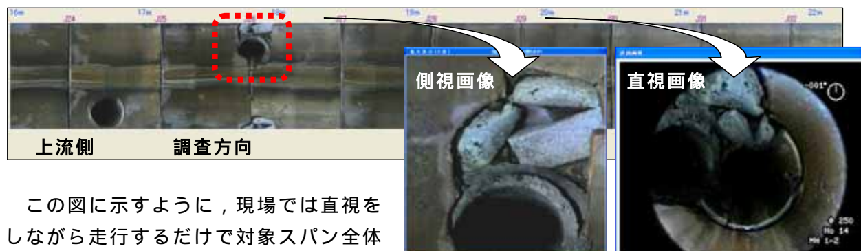
図-5 現場で取得した画像 〔 Image obtained from job site 〕
