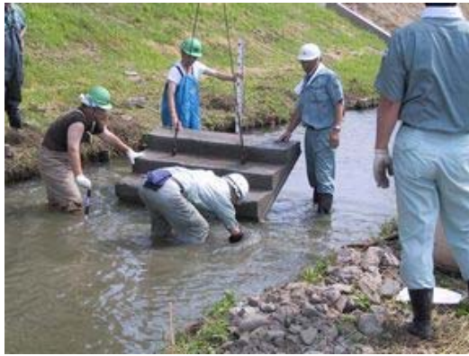
写真-1 実河川に浸漬したリン吸着コンクリート Phosphorous adsorption concrete soaked in actual river
