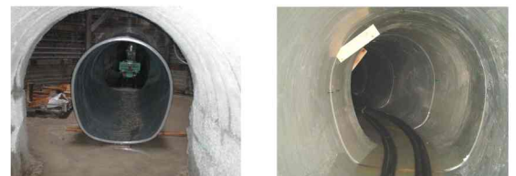
Fig.3 縦長馬蹄形FRPM管及び曲管設置状況 Special shape pipe and bend pipe of FRPM
