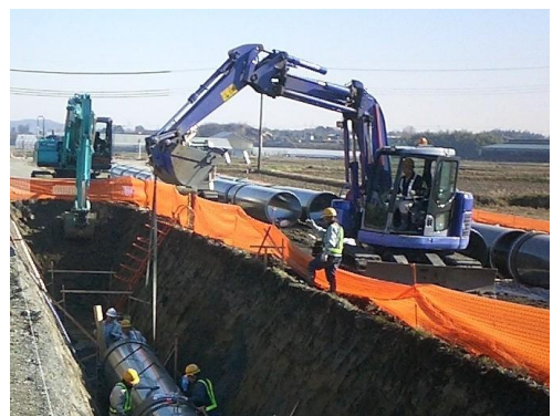
（写真-2）バックホウによる管布設
