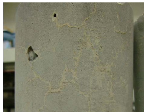
写真-1 エフロレッセンスの発生した供試体
