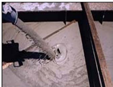
Fig.3 流動化処理土の打設 Concrete placing
