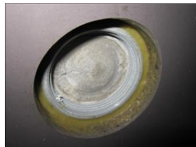
Pic3. グラウトホール充填状況
