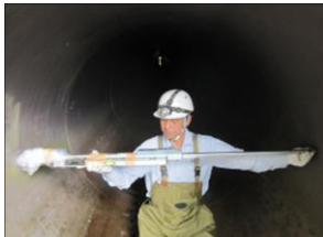
Pic2. 測定状況
