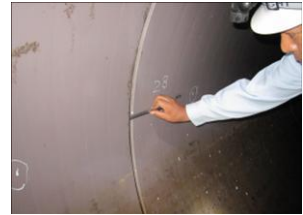
Pic4. 継手間隔測定
